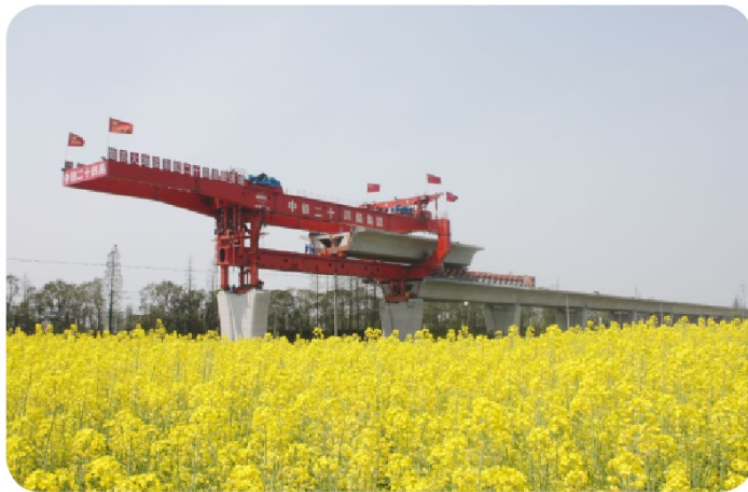
高速铁路建设施工现场
