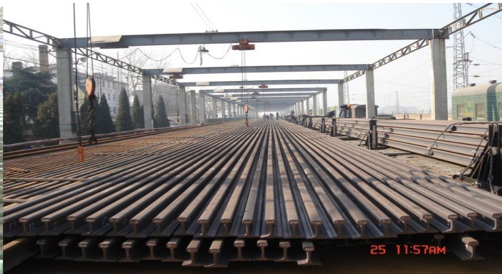
待焊的100m定尺钢轨 Рельсы мерной длиной 100м, подготовленные для сварки
