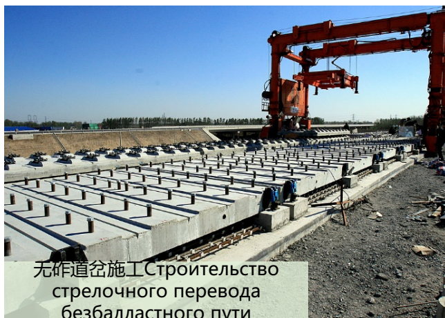
无砟道岔基础结构 Основная конструкция безбалластного пути
