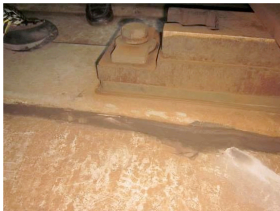
轨道板裂缝 Трещины рельсовой плиты
