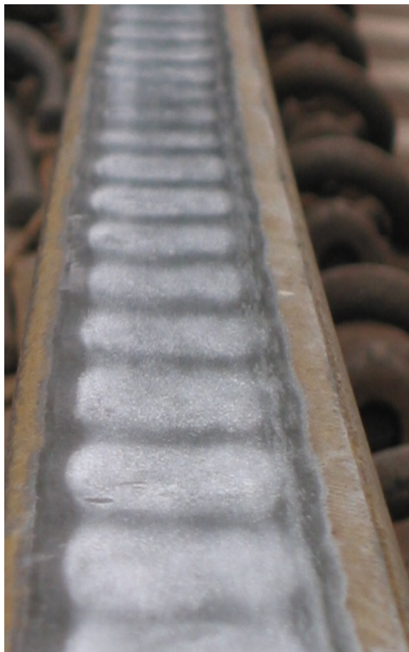
钢轨波磨 Волнообразный износ рельса
