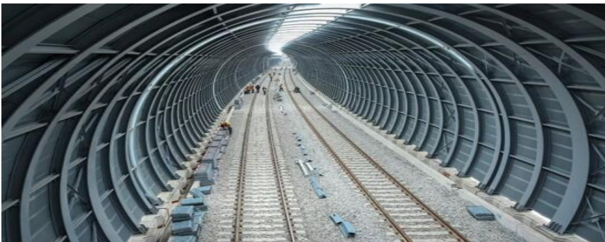
全球首例高铁全封闭式声屏障 Первый акустический экран полностью огражденный во всем мире.
