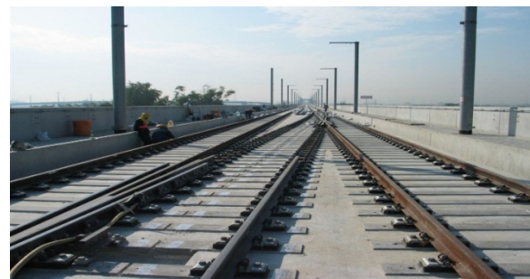
桥上无缝道岔Бесстыковой стрелочный перевод на мосту
