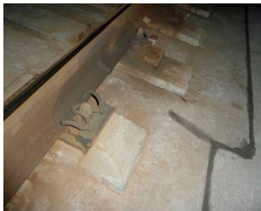
轨道板裂缝 Трещины рельсовой плиты
