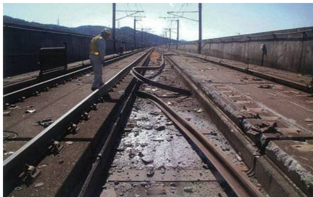
无缝线路胀轨跑道 Выброс бесстыкового пути
