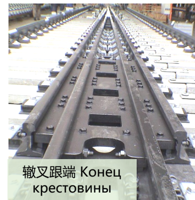
桥上无缝道岔结构 Бесстыковая конструкция стрелочного перевода на мосту
