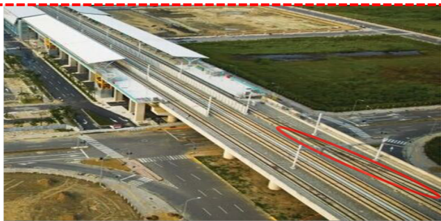
桥上无缝道岔Бесстыковой стрелочный перевод на мосту
